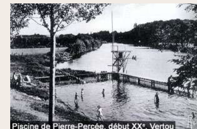
Piscine de Pierre-Percée, début XX e , Vertou
