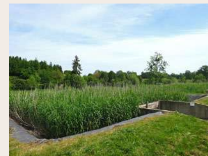
Étape de phytoépuration, station d'épuration
